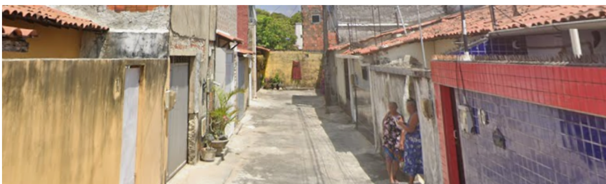
Figura 8 – Exemplo de rua sem calçadas
