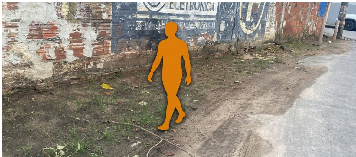
Figura 11 – Ausência total de pavimentação nos passeios (solo natural)
