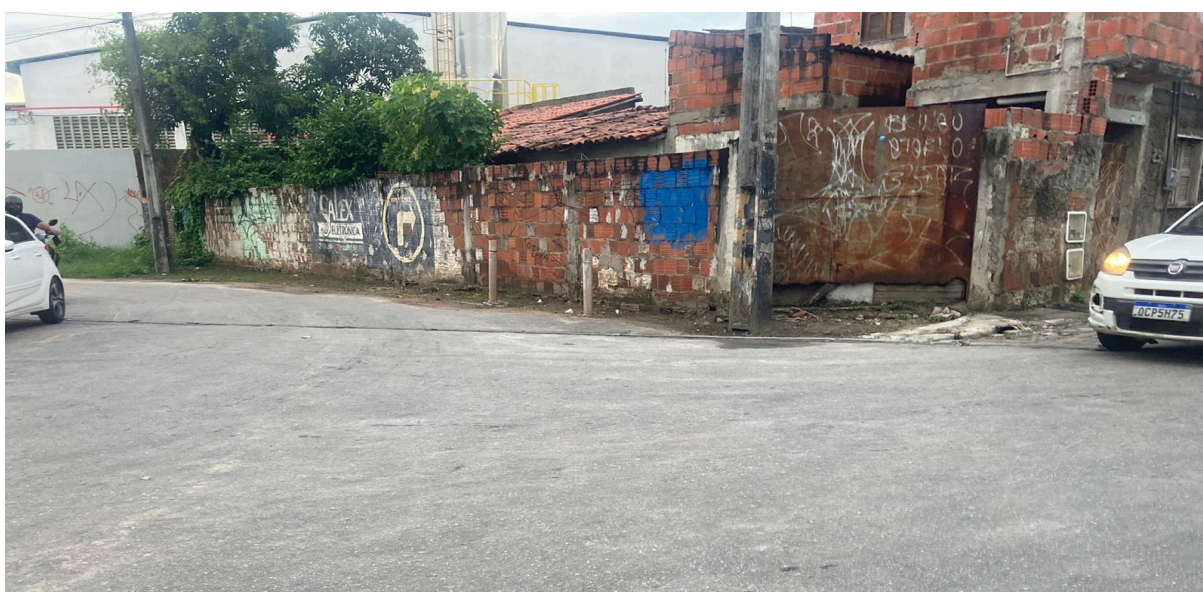
Figura 13 – Ausência de faixas de pedestres em nós de conflito
