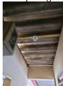
Figura 34 –instalações atuais do terminal rodoviário de passageiros – TRP
