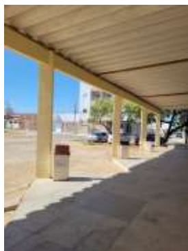
Figura 29 –instalações atuais do terminal rodoviário de passageiros – TRP
