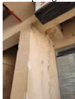
Figura 32 –instalações atuais do terminal rodoviário de passageiros – TRP
