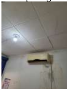
Figura 33 –instalações atuais do terminal rodoviário de passageiros – TRP
