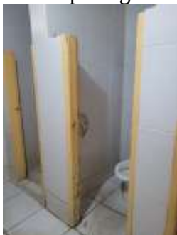
Figura 31 –instalações atuais do terminal rodoviário de passageiros – TRP
