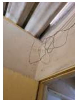
Figura 30 –instalações atuais do terminal rodoviário de passageiros – TRP
