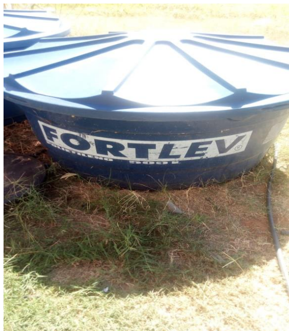
Figura 7- Reservatório de água produzida tratada
