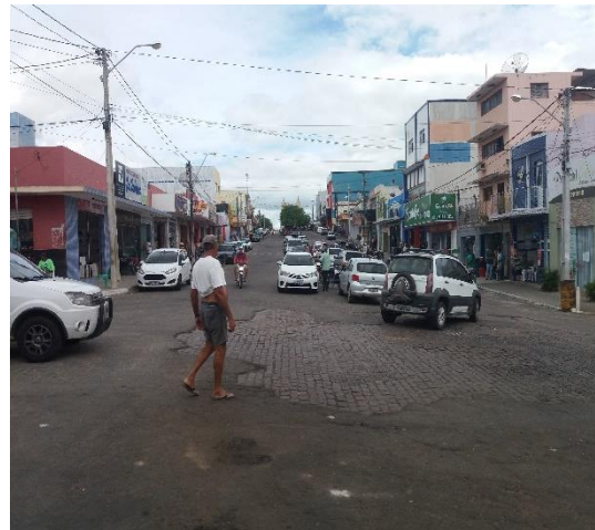
Figura 8: Pavimentação precária da interseção.
