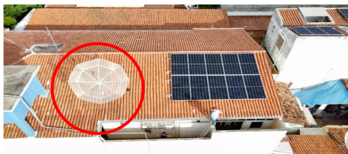
FIGURA 7. Vista superior do sistema FV 1.
