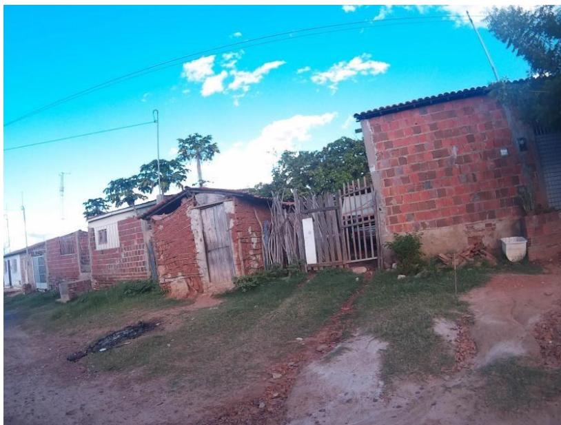
Figura 35 - Casa de taipa no bairro Manoel Deodato Fonte: DADOS DA PESQUISA (2015)
