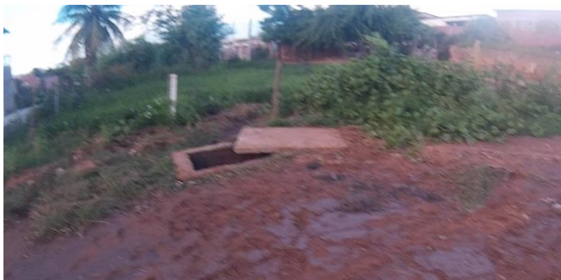
Figura 37 – Bueiro a céu aberto Fonte: DADOS DA PESQUISA (2015)
