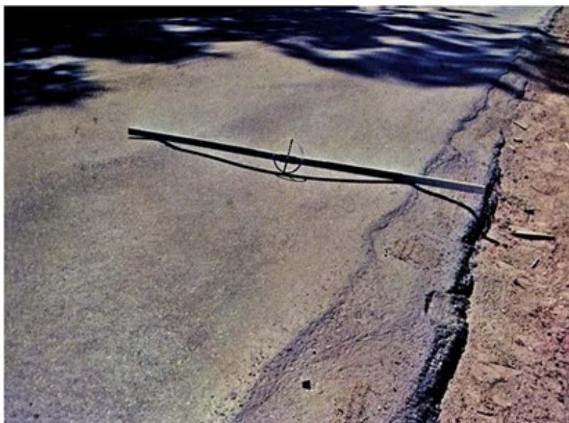
Figura 6 – Afundamento: Trilha de roda
