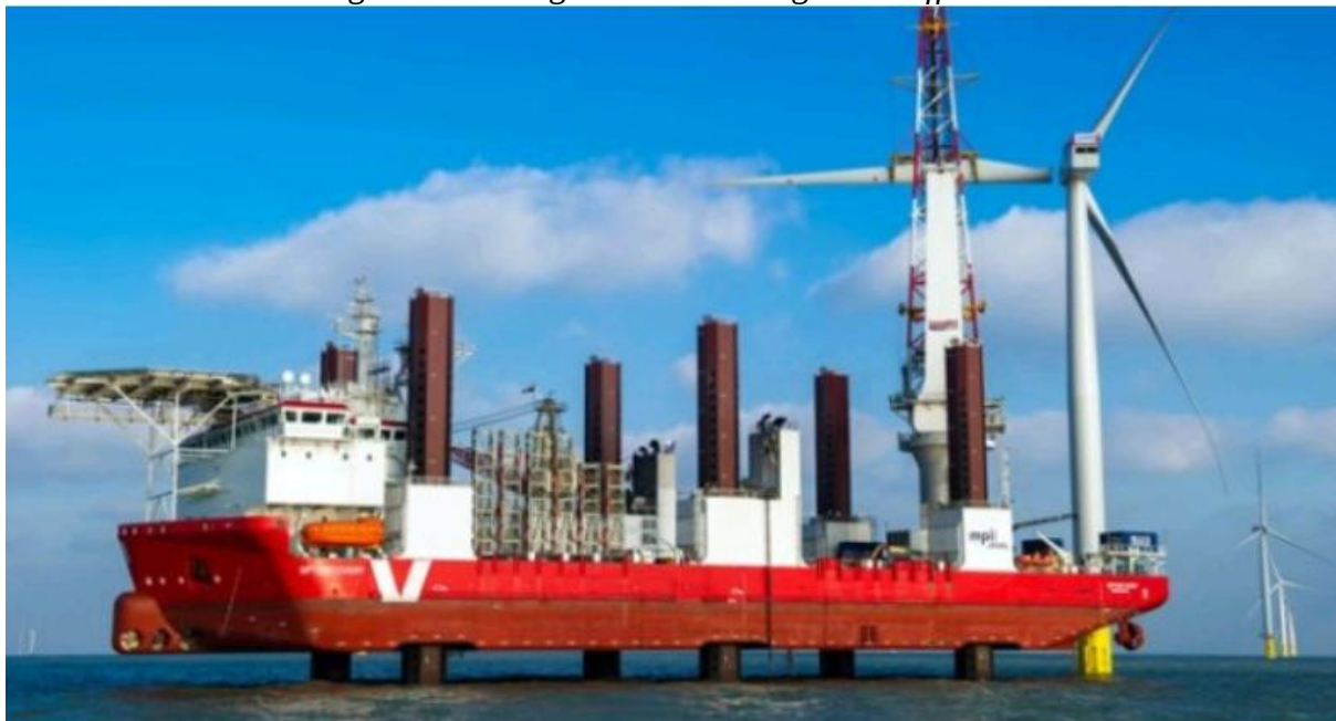
Figura 9: Montagem de um aerogerador offshore .
