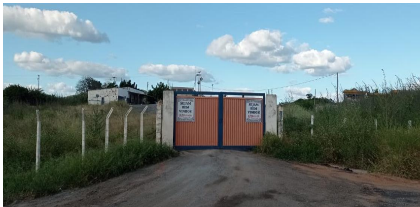
Figura 5: Usina BRITAJA. (a) Entrada principal da Usina; (b) Estocagem do pó de pedra.
