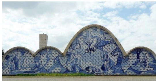
Figura 5b: Fachada Sudoeste. Fonte: Iepha-MG
