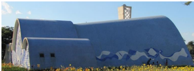
Figura 8: Vista lateral da edificação Fonte: Iepha/MG
