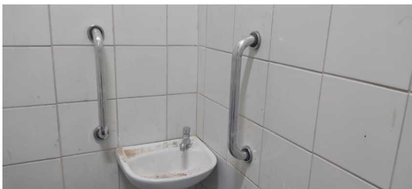
Figura 14 – Banheiros acessíveis do Setor 8
