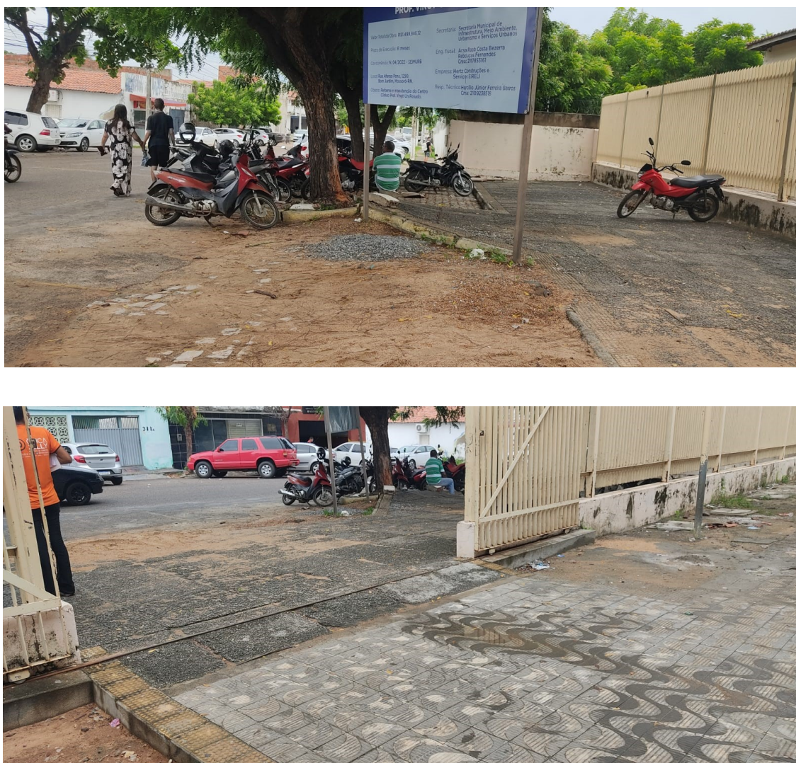
Figura 16 – Calçada do centro clínico
