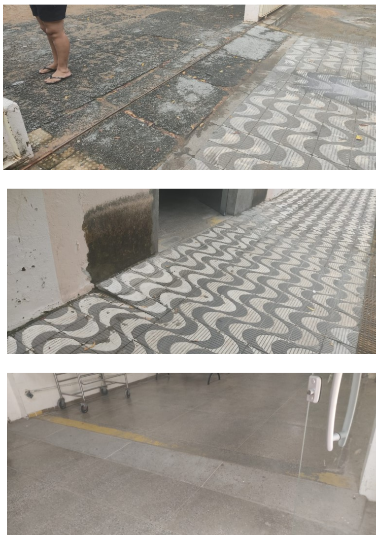
Figura 13 – Rampas de acesso do centro clínico
