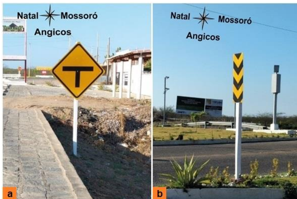
Figura 49 – Sinalização vertical de advertência: a) interseção em “T” e b) marcador de perigo
