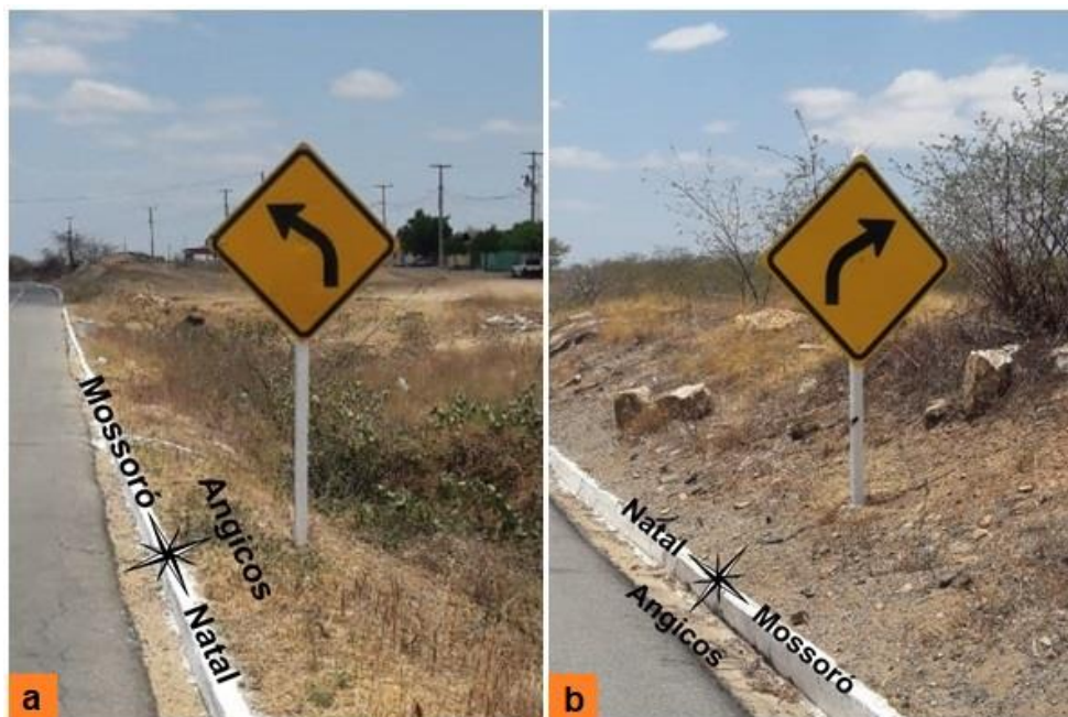
Figura 50 – Sinalização vertical de advertência: a) curva a esquerda e b) curva a direita
