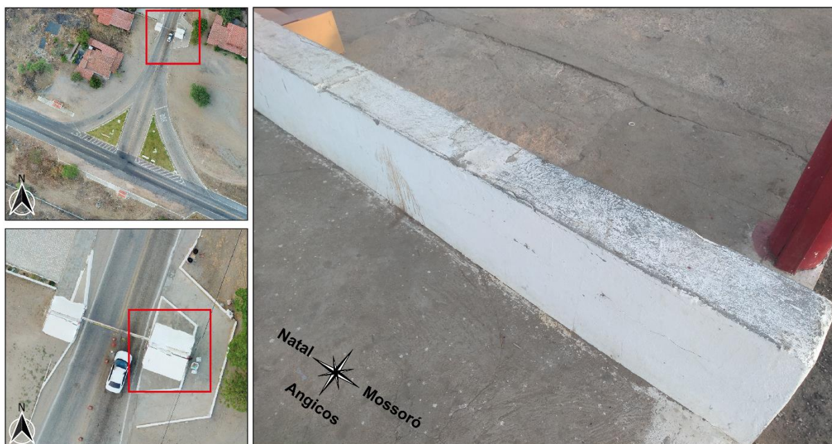
Figura 63 – Suporte de alvenaria para banco no abrigo de ônibus 2
