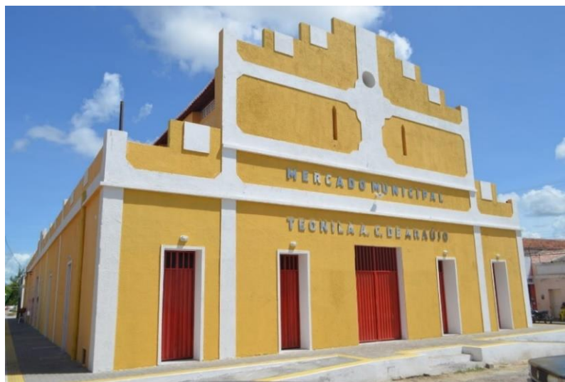
Figura 30 – Fachada do Mercado Municipal Teonila A. C. de Araújo em Angicos – RN
