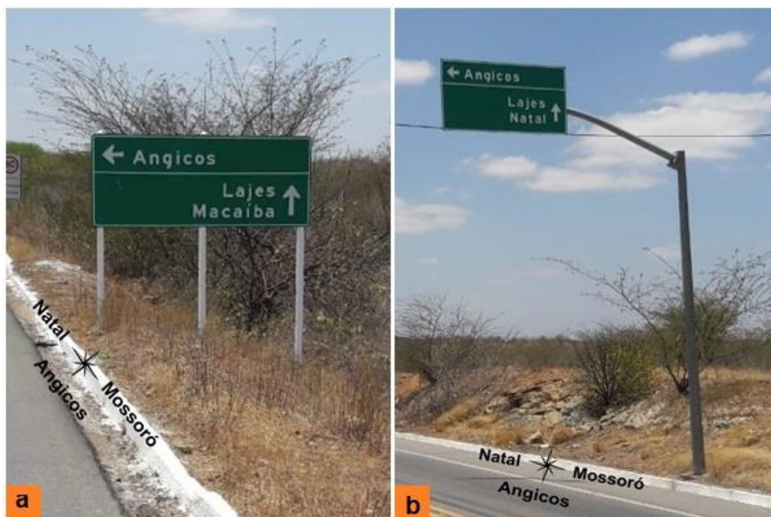
Figura 55 – Sinalização vertical de indicação: a) coluna tripla e b) braço projetado
