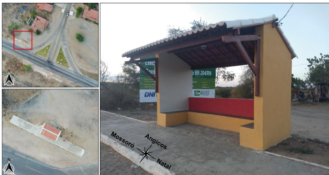
Figura 64 – Parada ônibus localizada na BR-304 no sentido Natal – Mossoró
