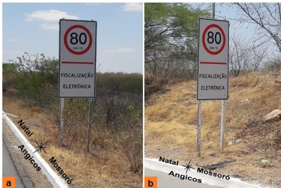
Figura 51 – Sinalização vertical de regulamentação: a) e b) limite de velocidade
