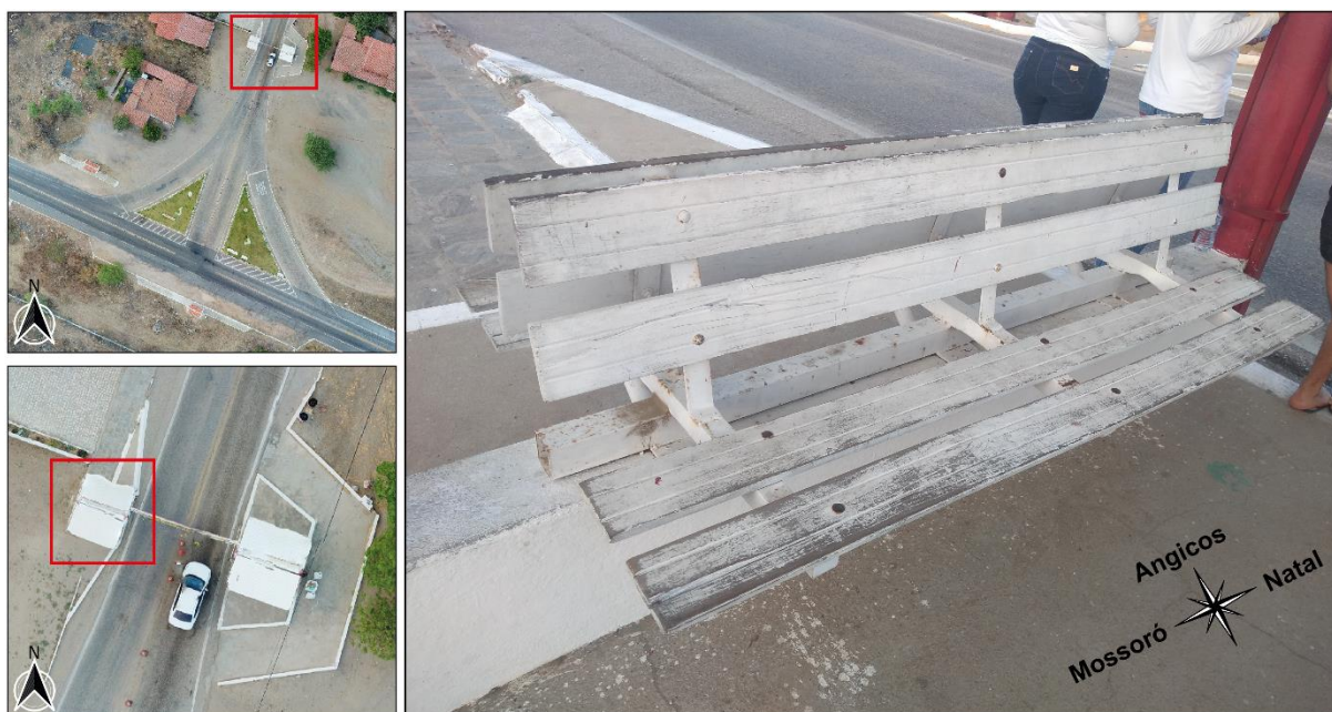
Figura 62 – Banco de madeira no abrigo de ônibus 1
