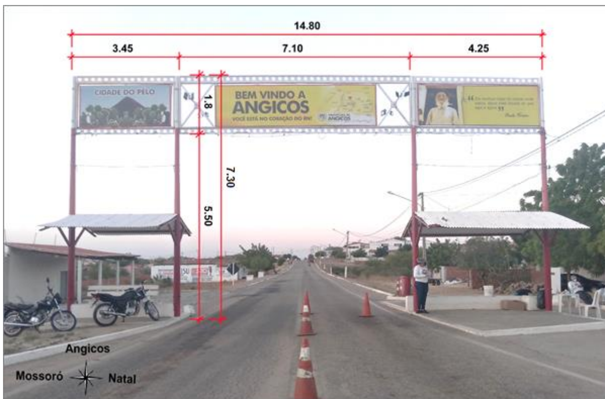
Figura 61 – Medidas aproximadas (em metros) do pórtico de entrada ao município de Angicos – RN
