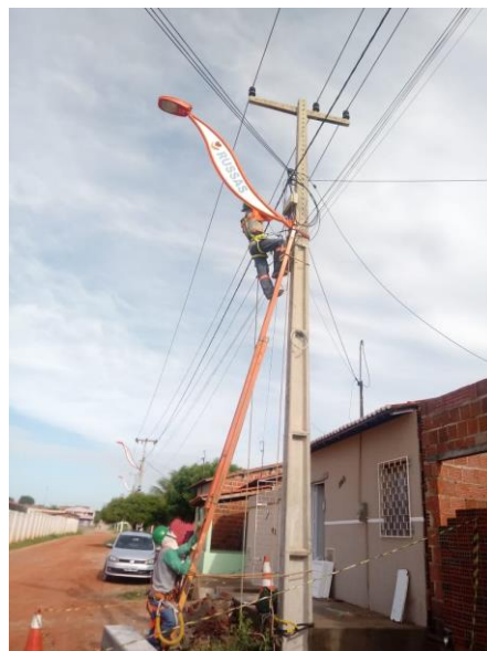
Figura 4: Eletricista realizando desligamento de ramais conectados a caixa de derivação (Autoria Própria, 2019).
