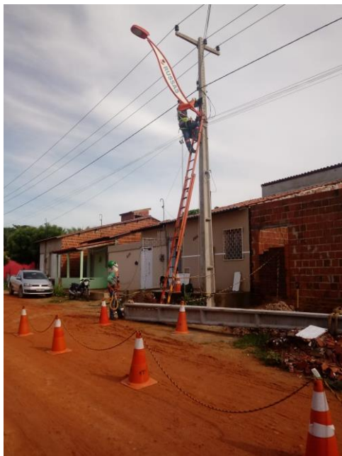
Figura 8: Eletricista realizando desligamento de BT (Autoria Própria, 2019).
