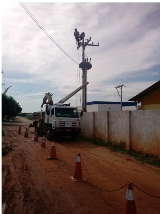
Figura 9: Colaborador realiza aparelhagem do poste para receber os condutores de média tensão (Autoria Própria, 2019).
