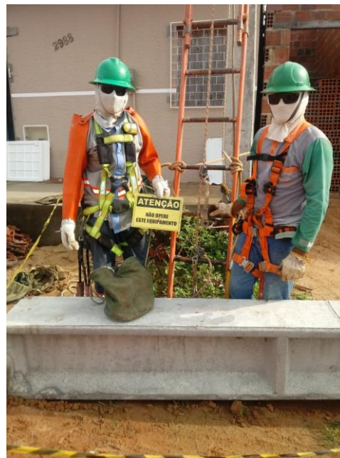
Figura 10: Colaboradores com equipamentos de proteção individual e coletiva utilizados para execução do trabalho (Autoria Própria, 2019).
