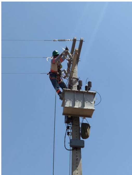
Figura 3: Eletricista instalando chave fusível de proteção de transformador de potência (Autoria Própria, 2019).
