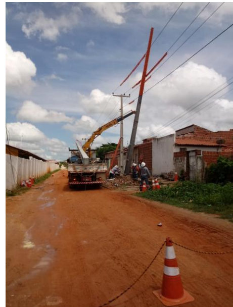
Figura 6: Munck utilizado para içamento de poste (Autoria Própria, 2019).
