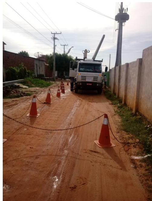
Figura 7: Sinalização por meio de cones e corda para delimitação de área de trabalho (Autoria Própria, 2019).
