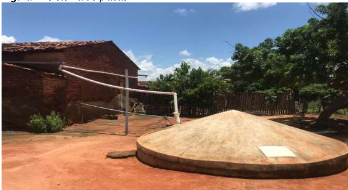
Figura 7: Cisterna de placas
