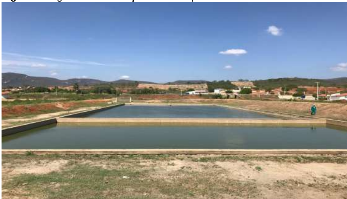
Figura 8: Lagoa de estabilização do município de José da Penha/RN
