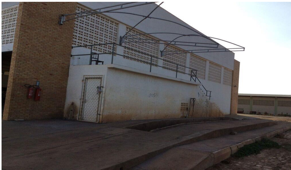
Figura 6 – Rampa utilizada para rotina de limpeza e lubrificação dos veículos.
