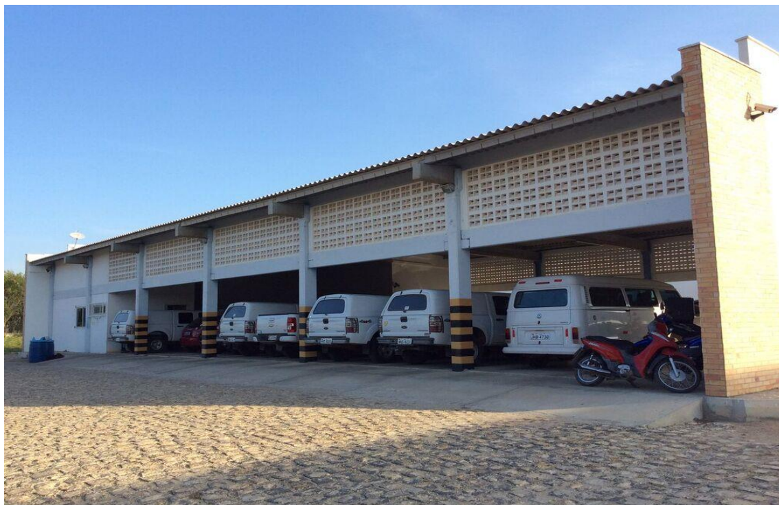
Figura 3 – Garagem dos veículos de pequeno porte.
