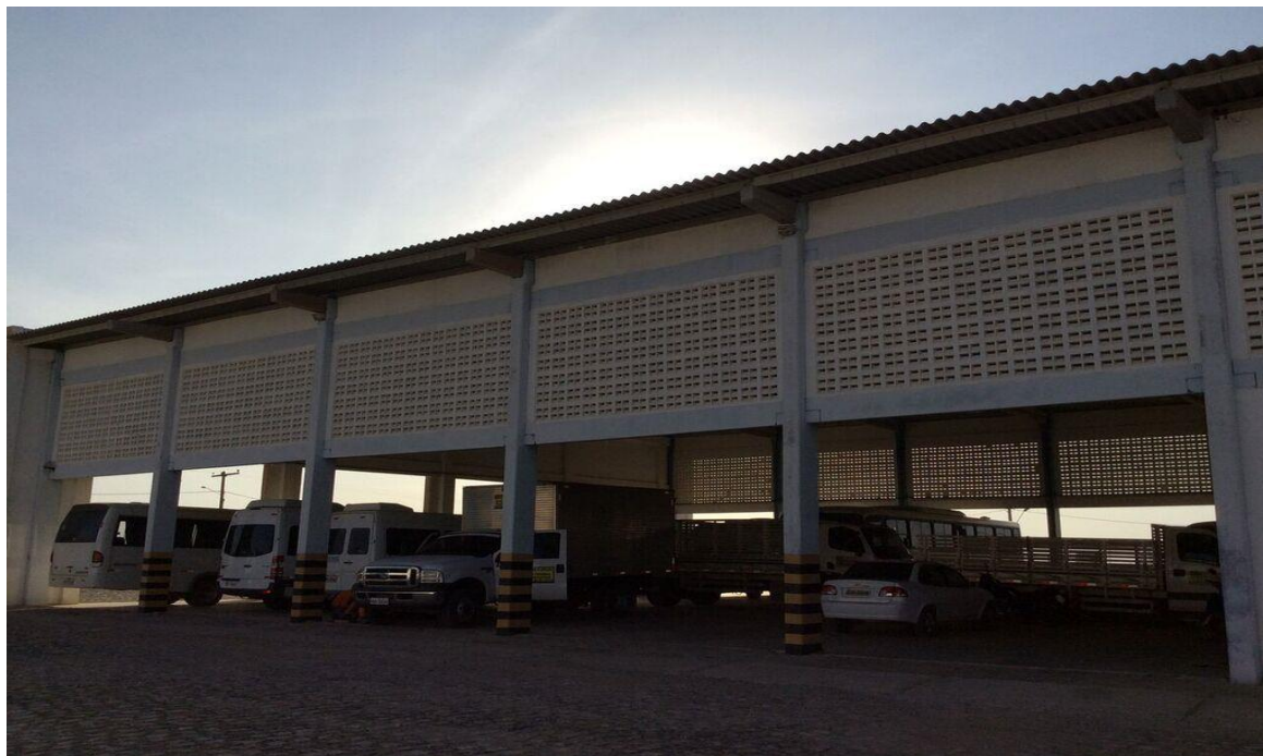
Figura 4 – Garagem dos veículos de grande porte.
