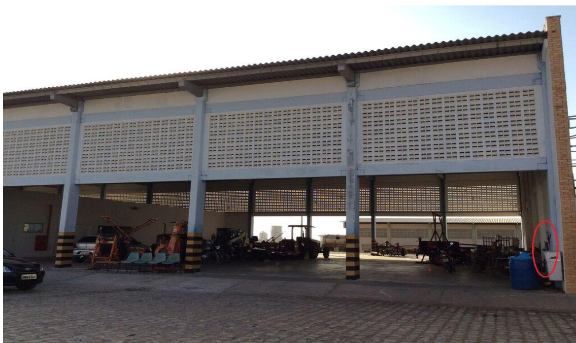
Figura 5 – Garagem do maquinário agrícola.
