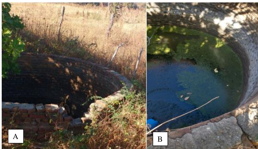
Figura 17- Poço à montante da barragem subterrânea. (a) Vista da parede do poço. (b) Vista da água acumulada no poço.
