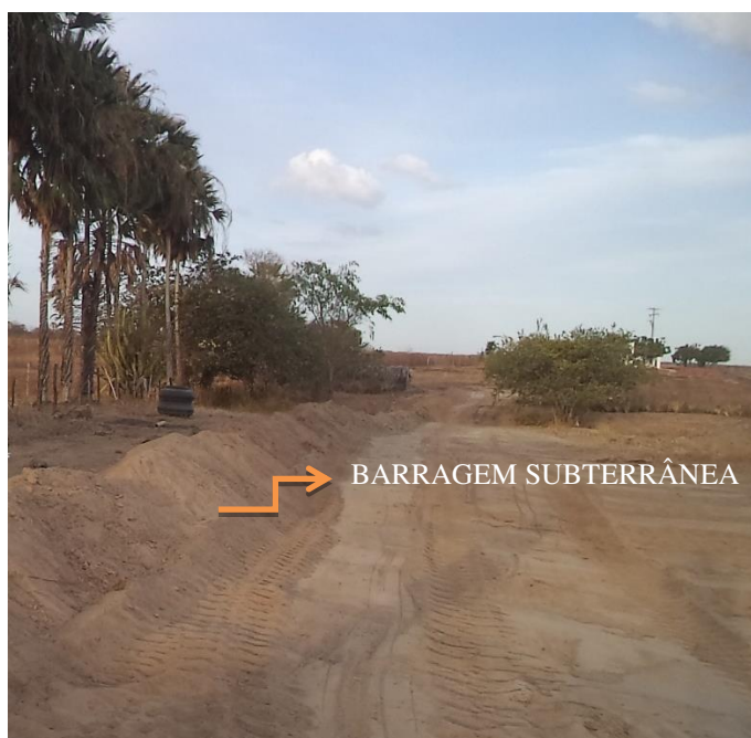
Figura 16- Barragem subterrânea no Sítio Timbaúba I
