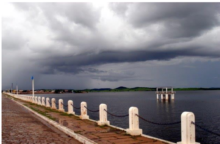
Figura 4- Açude de Coremas - PB
