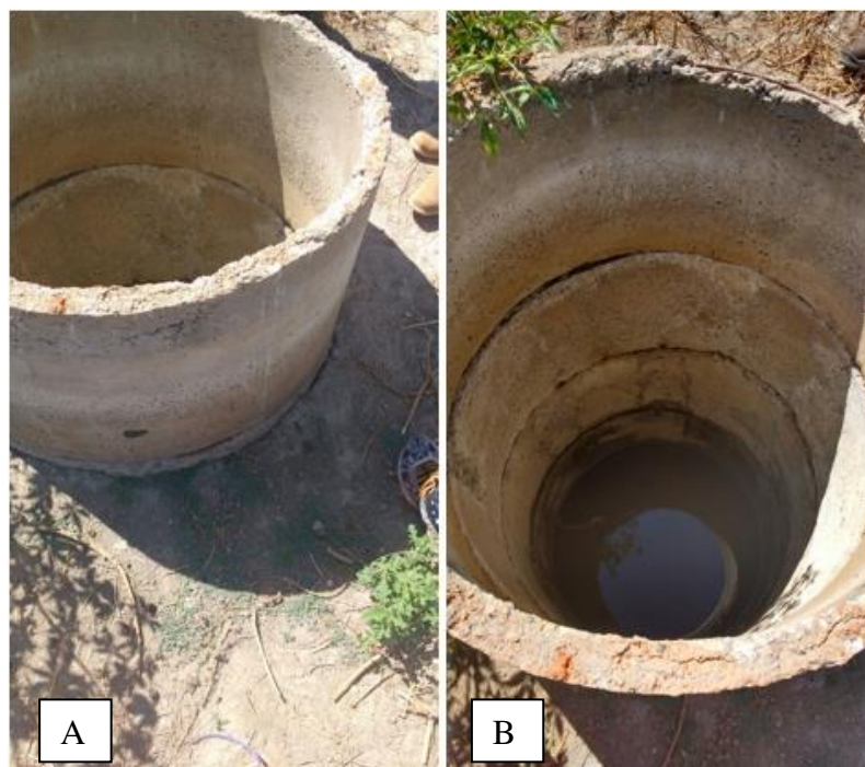
Figura 19- Poço à montante da barragem Subterrânea. (a) Vista da parede do poço. (b) Vista da água acumulada no poço.
