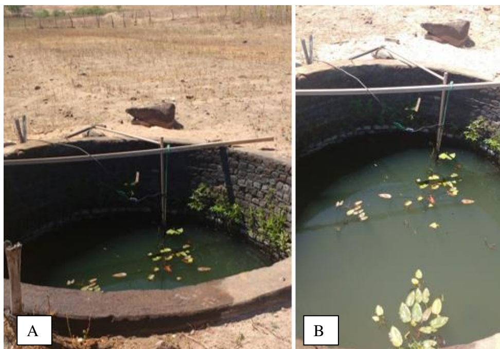
Figura 21- Poço à montante da barragem subterrânea. (a) Vista da parede do poço. (b) Vista da água acumulada no poço.
