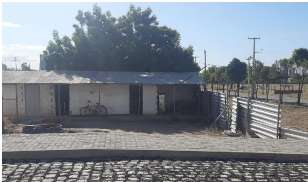
Figura 13 - Tapume instalado na obra da empresa A Fonte: Autoria própria (2023).
