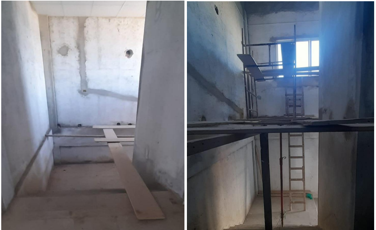
Figura 15 - Andaimos para trabalho em altura instalado na empresa A Fonte: Autoria própria (2023).
