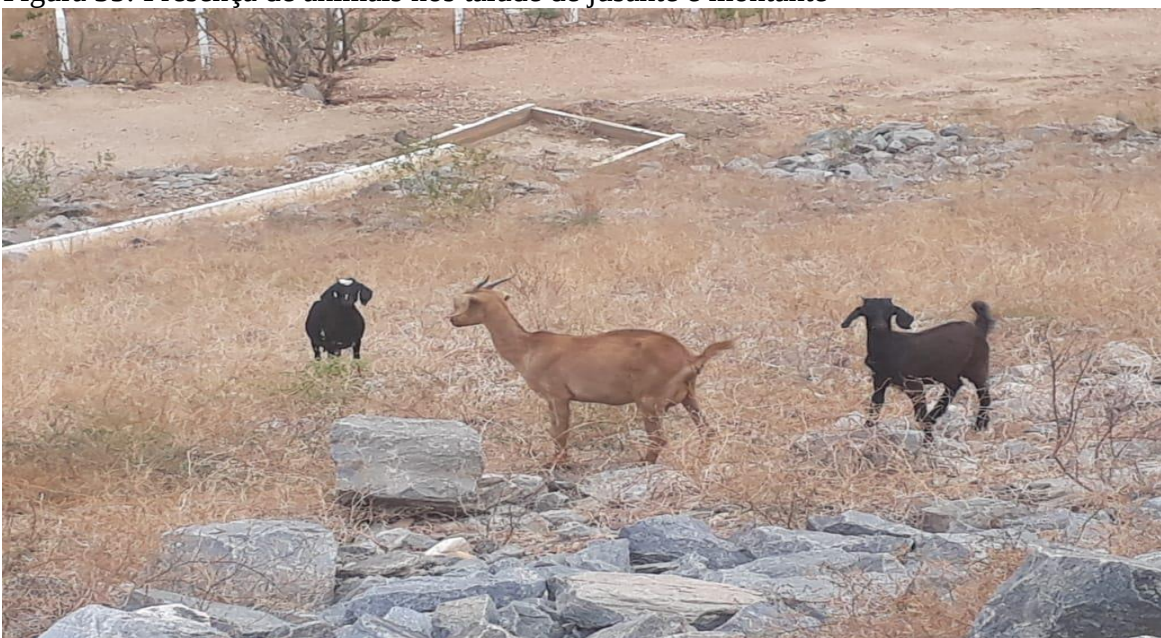
Figura 35: Presença de animais nos talude de jusante e montante
