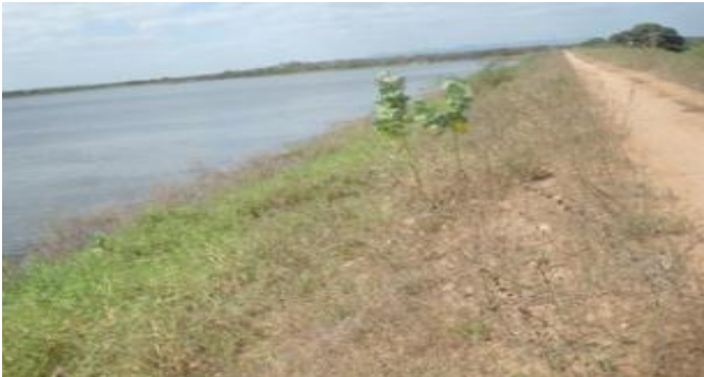
Figura 17: Barragem de Direito (Paraíba), vegetação no talude de montante
