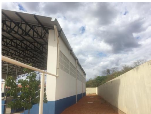
Figura 15 – Cobertura do ginásio da E. M. Alfredo Silvério
