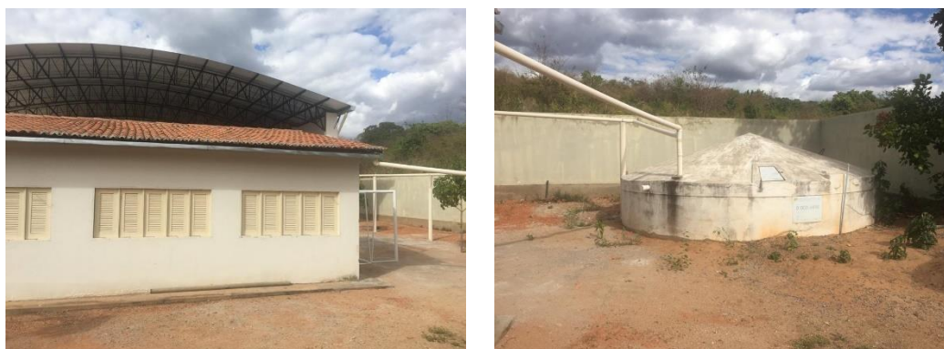
Figura 12 – Sistema de captação da E. M. Alfredo Silvério
