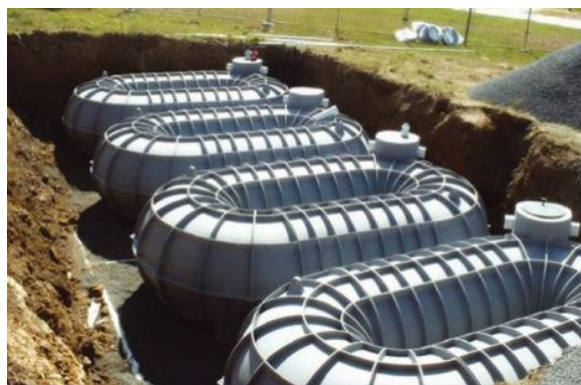
Figura 4 – Exemplo de reservatório para água da chuva
