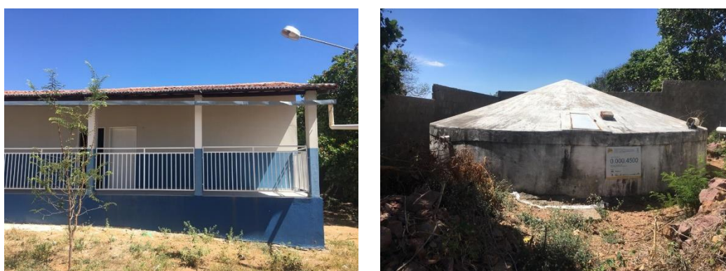
Figura 13 – Sistema de captação E. M. Manoel Joaquim de Sá
