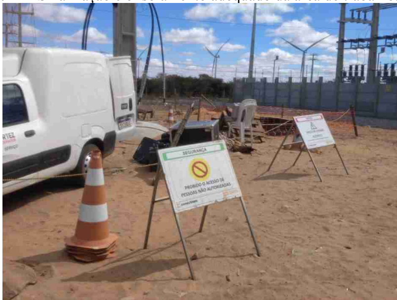
Figura 14 - Sinalização e o isolamento adequado da área de trabalho.
