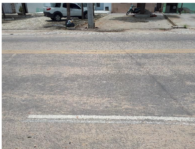
Figura 6. Desgaste.
