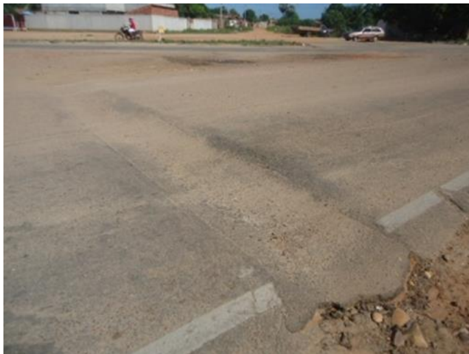
Figura 7: Afundamento plástico em trilha de roda (ATP)
