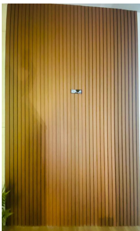
Figura 6: Aplicação do painel ripado externo em WPC ( Autoria própria)
