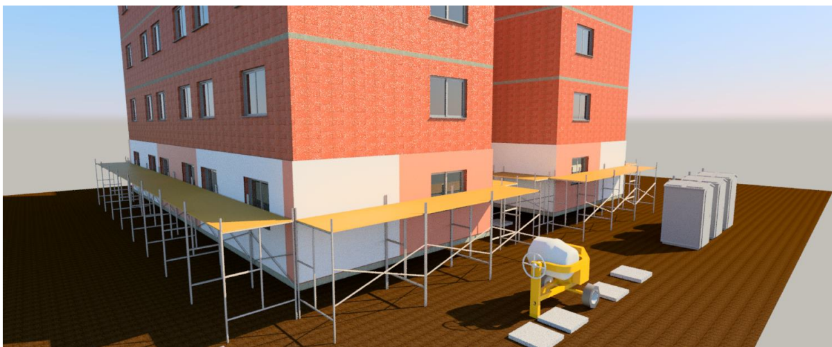
Figura 47 - Vista renderizada da montagem dos andaimes
