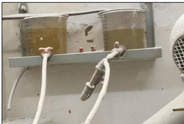
Figura 13 - Rotômetros (Flowmeter) – Controladores de Vazão.
