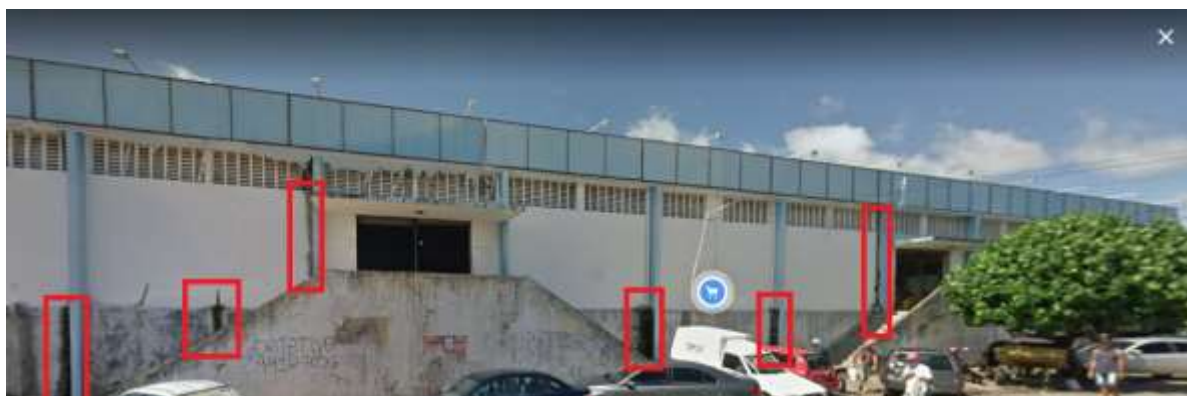
Figura 21 – Fachada antes do Reparos
