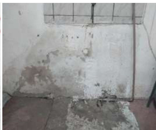
Figura 28 – Presença de infiltração e Destacamento da pintura do Boxe 1. (a) Infiltração e destacamento de pintura abaixo de uma torneira; (b) Infiltração e destacamento de pintura próximo a instalações hidráulicas.
