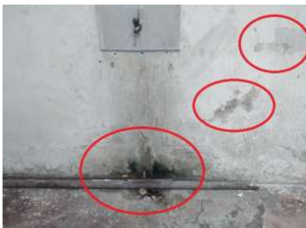
Figura 28 – Presença de infiltração e Destacamento da pintura do Boxe 1. (a) Infiltração e destacamento de pintura abaixo de uma torneira; (b) Infiltração e destacamento de pintura próximo a instalações hidráulicas.
