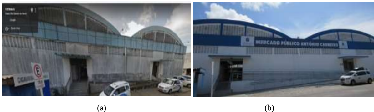
Figura 15 – Fachada do MPAC. (a) Fachada Antes da Reforma; (b) Fachada após a reforma.
