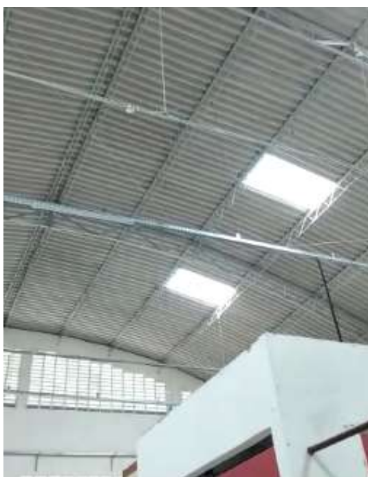
Figura 17 - Telhas transparentes na cobertura do MPAC
