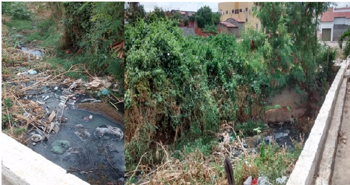
Figura 10 - Lançamentos de esgoto a céu aberto em terreno baldio no São Benedito
