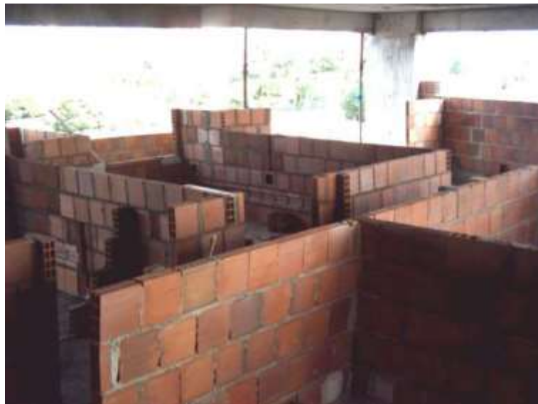
Foto 1: Pacote de Alvenaria.
