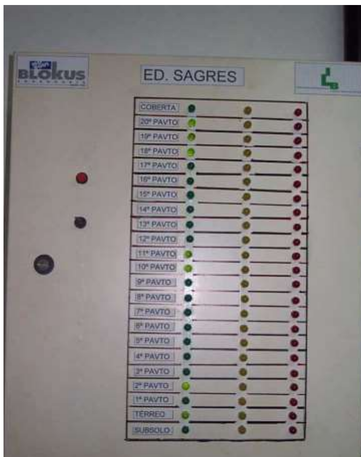
Foto 11: Andon para acompanhamento dos serviços instalado na sala do engenheiro.
