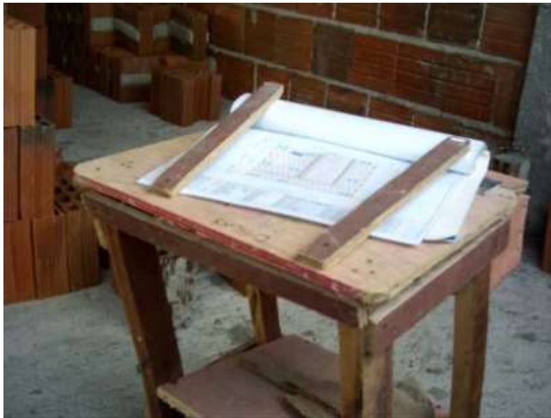
Foto 5: Projeto de Paginação de Alvenaria.
