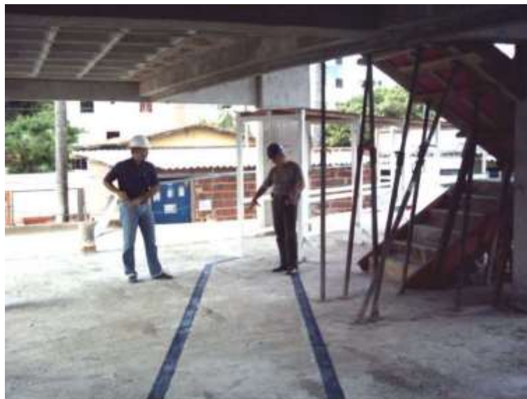
Foto 2: Racionalização dos fluxos de transportes no canteiro.
