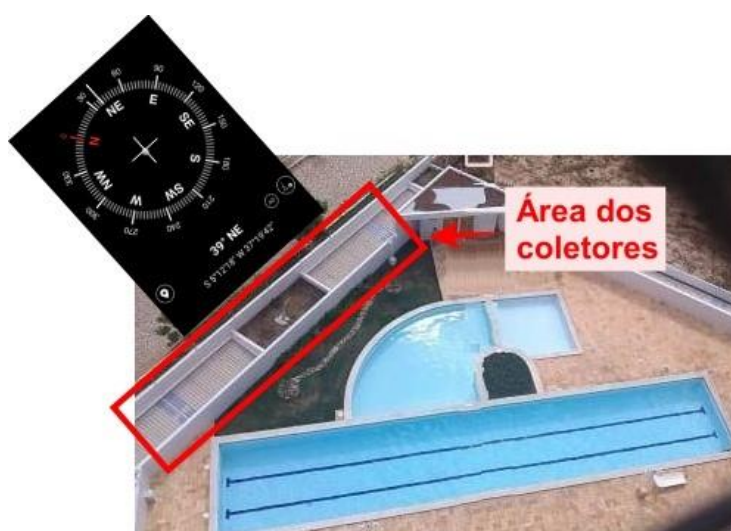
Figura 10. Área disponível para instalação dos coletores
