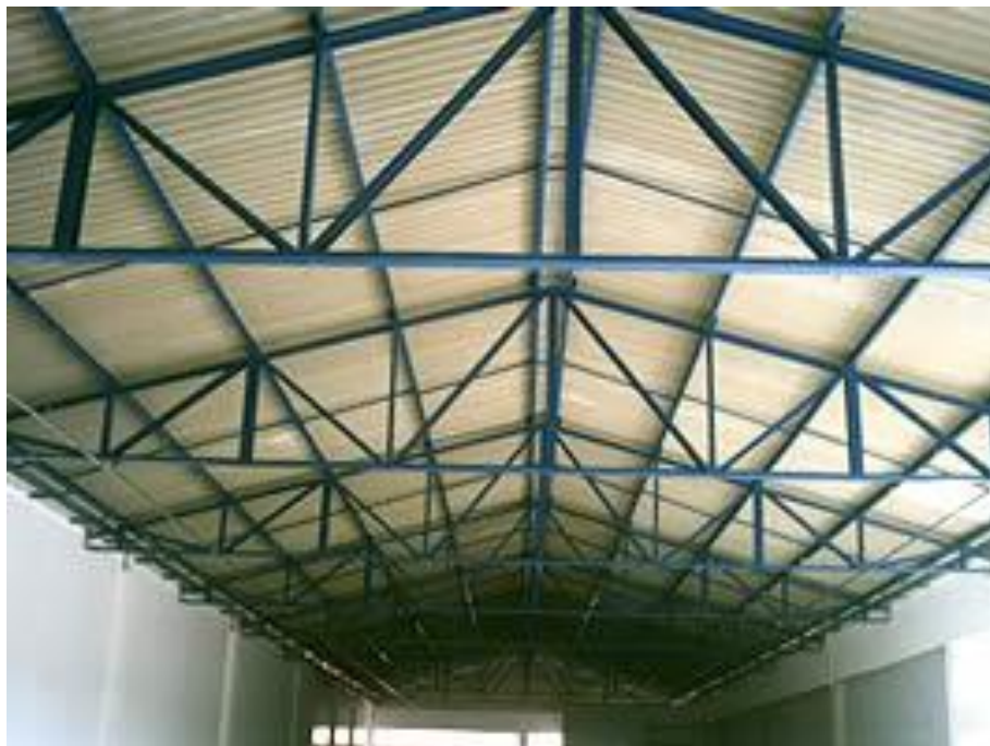
Figura 11 - Exemplo de tesoura de aço
