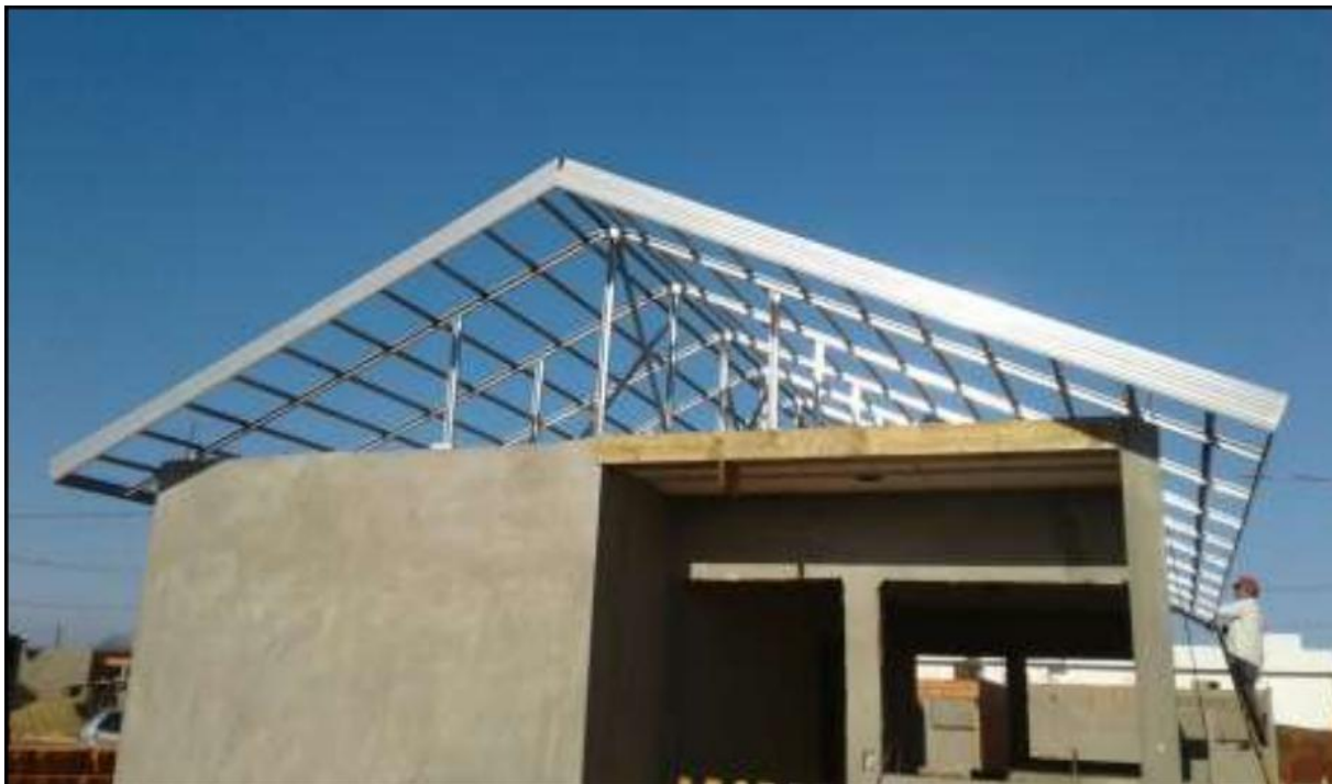
Figura 25 – Exemplo de utilização do engradamento metálico
