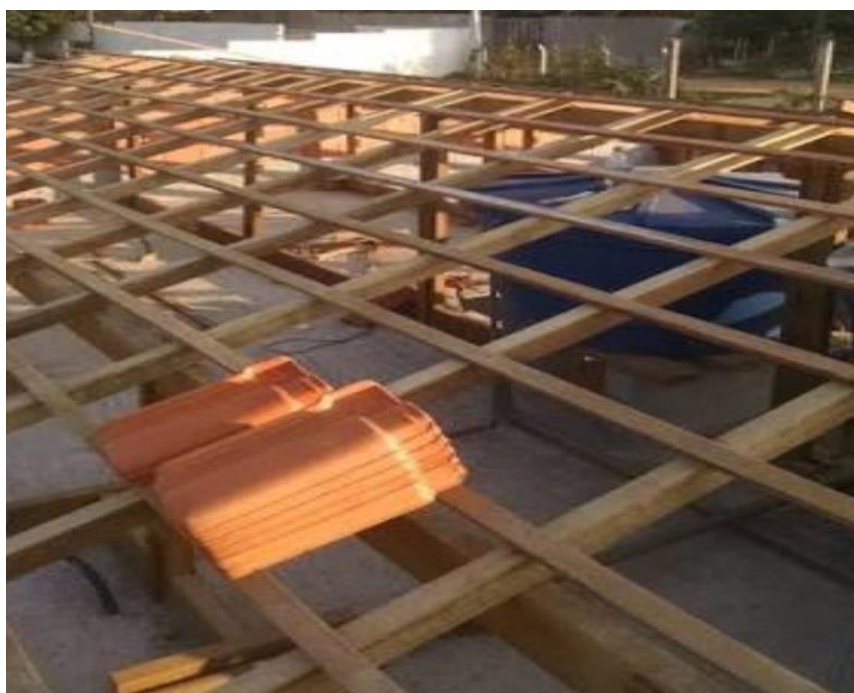
Figura 18 – Exemplo de utilização de caibros e ripas
