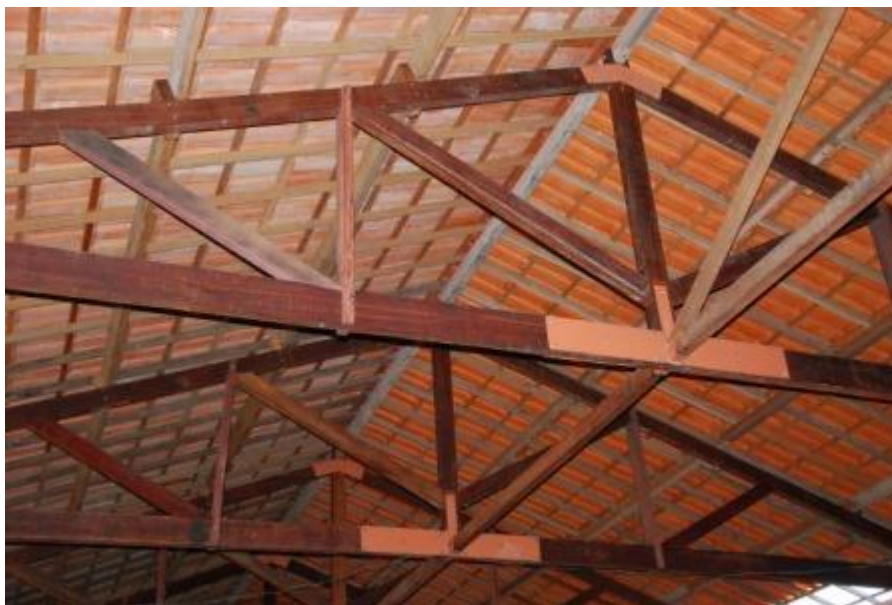
Figura 10 – Exemplo de tesoura de madeira
