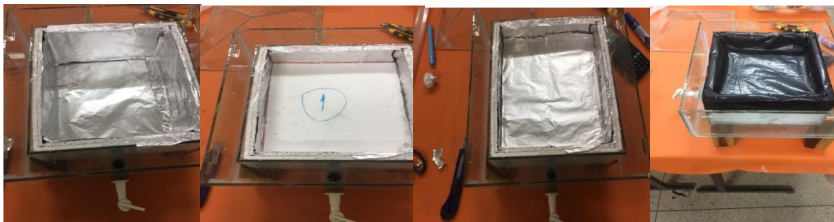
Figura 2 – Etapas de construção do tanque.
