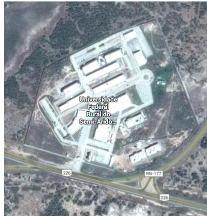
Figura 3: Edificações do campus
