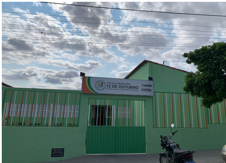
Figura 6: Fachada da Escola Municipal 12 de Outubro
