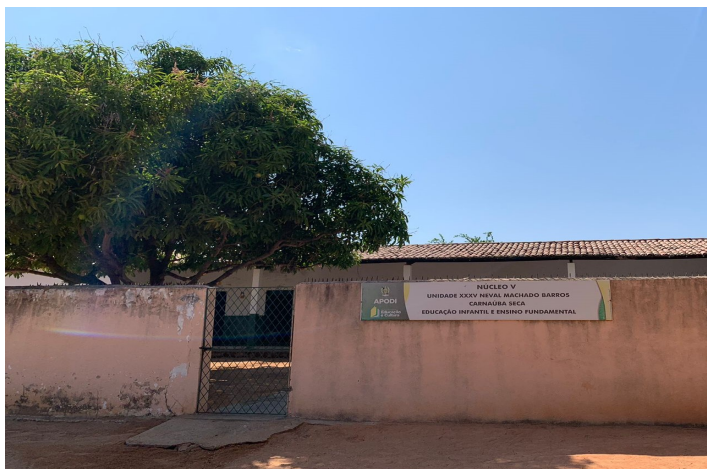
Figura 9: Fachada da Escola Municipal Neval Machado Barros
