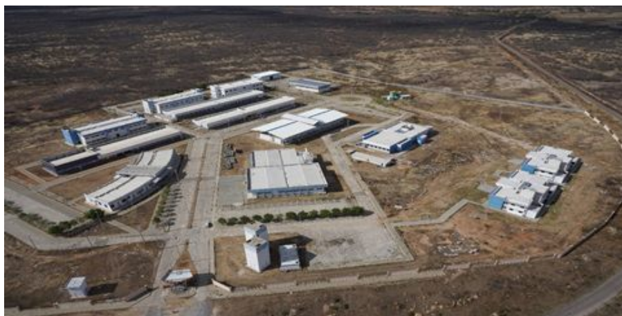
Figura 04: Vista Superior da UFERSA Campus Pau dos Ferros.
