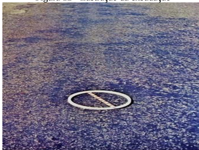
Figura 12 - Ilustração da exsudação
