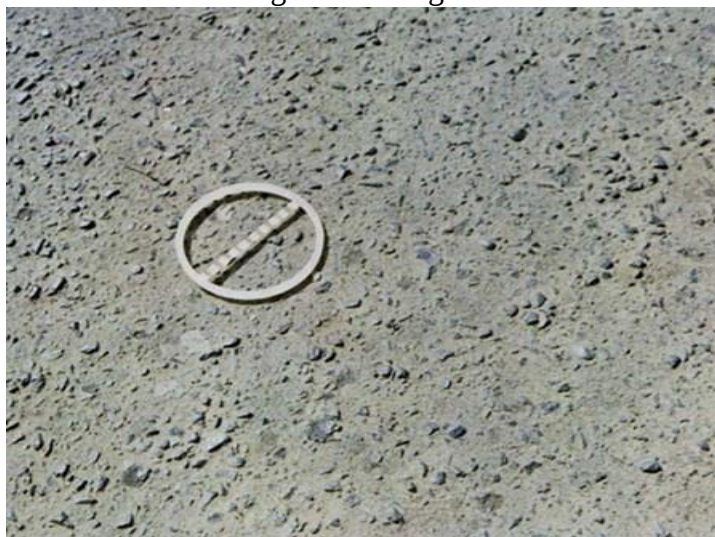
Figura 9 - Desgaste
