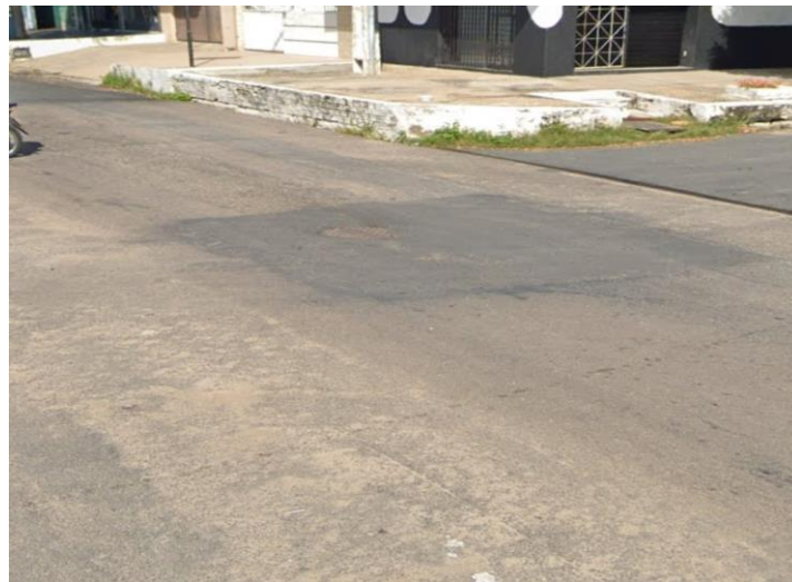
Figura 18 - Remendo
