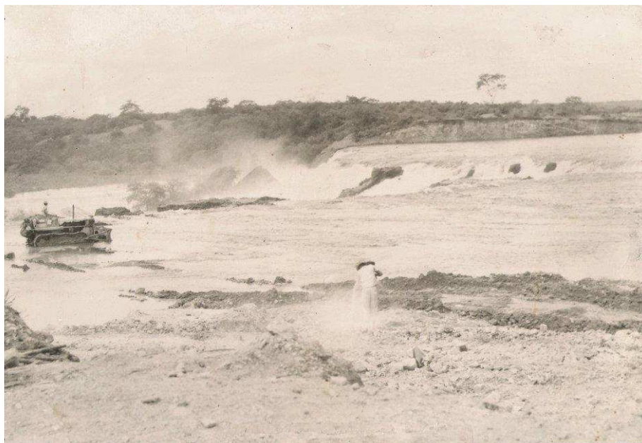
Figura 35 - Construção da Barragem de Pau dos Ferros
