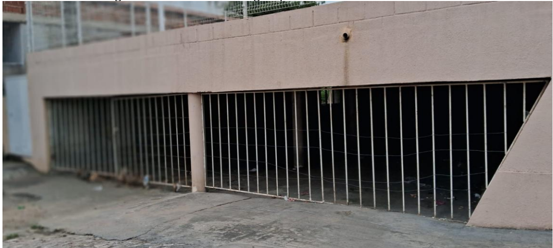
Figura 25 - Galeria de drenagem pluvial em área urbana.
