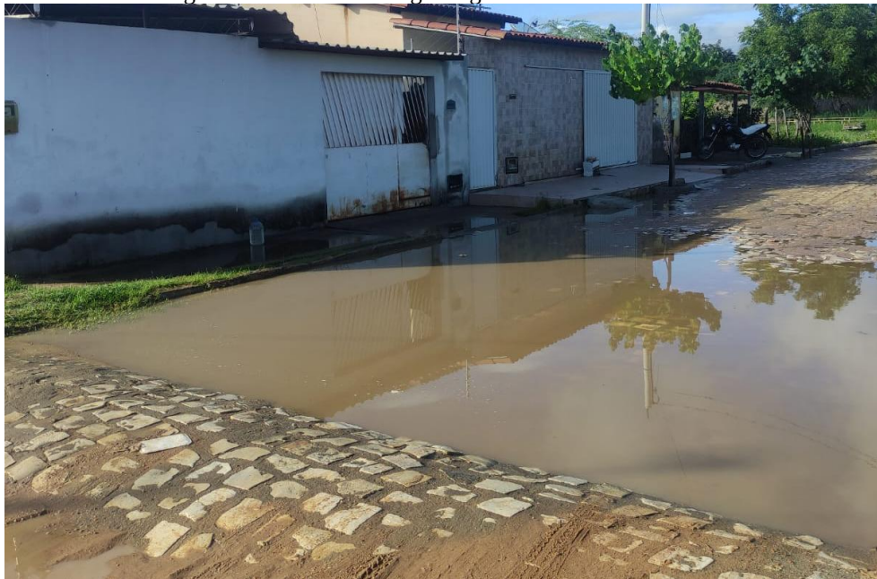
Figura 14 - Acúmulo de água registrado no bairro Carvão.
