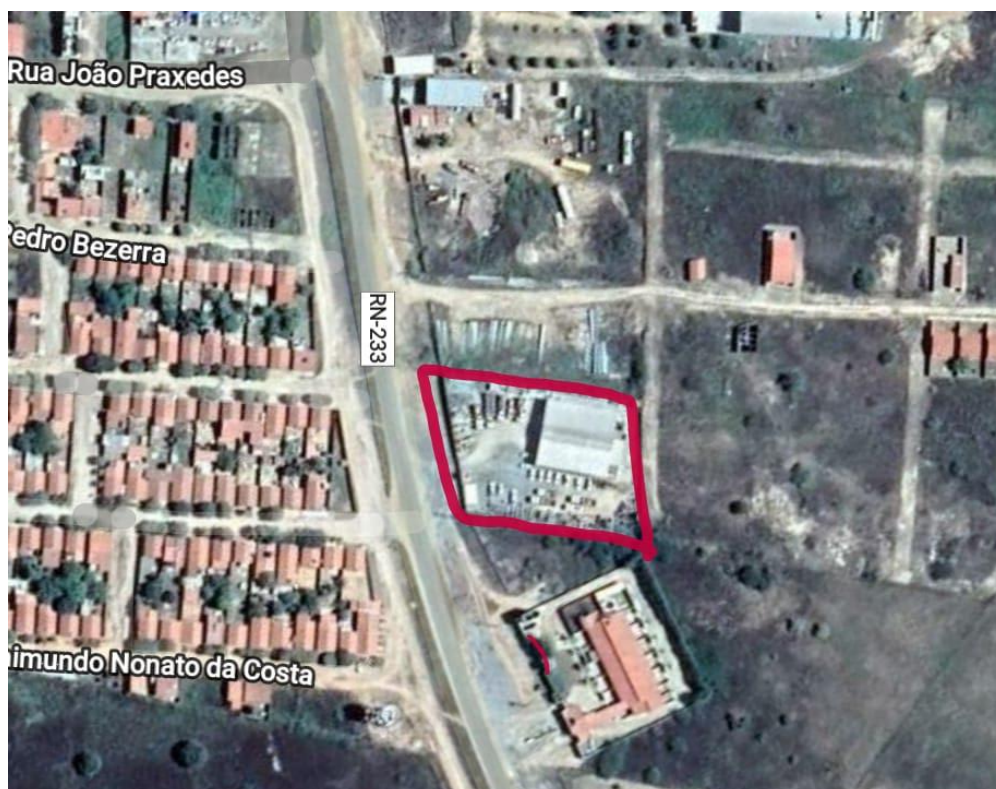
Figura 3. Localização da edificação em situação (Google Earth, 2019).
