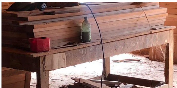
Figura 34 – Armazenamento inadequado de produtos químicos na unidade de produção
