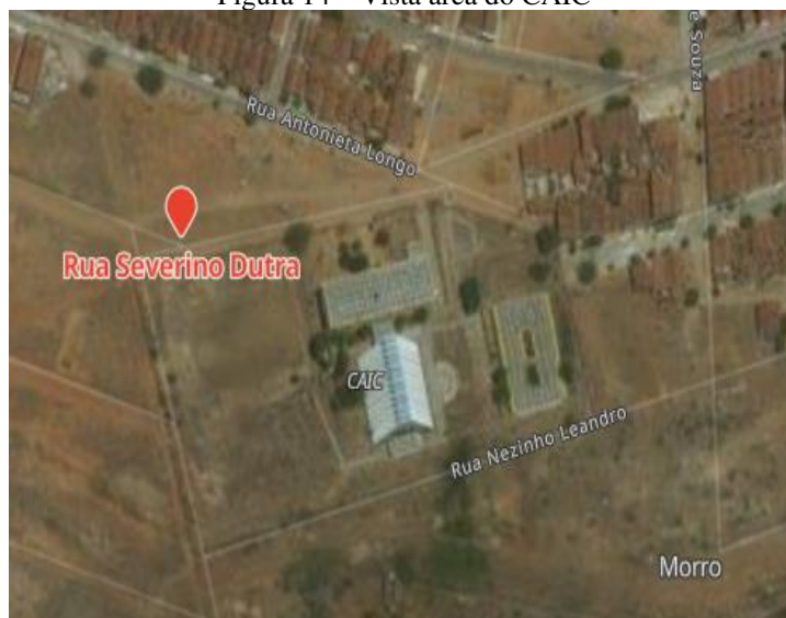
Figura 14 – Vista área do CAIC
