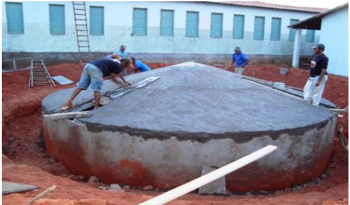
Figura 8. Instalação de uma cisterna do programa cisternas nas escolas
