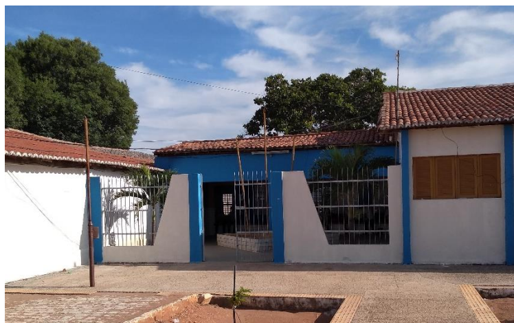
Figura 3 – Fachada da EEPJA
