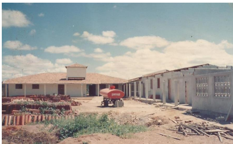
Figura 2 – Escola EFAMEL em seu processo inicial de construção
