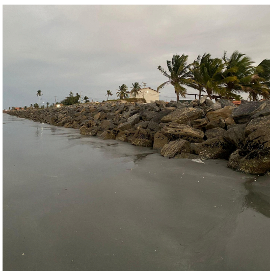
Figura 7. Enrocamento construído para proteção costeira na Praia de Barreiras. (Autoria própria)
