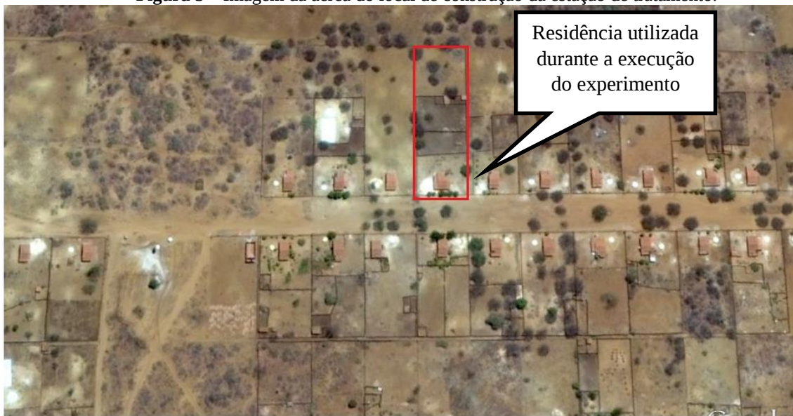
Figura 5 – Imagem da aérea do local de construção da estação de tratamento.
