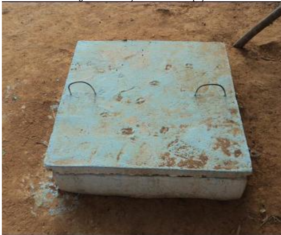
Figura 7 - Ilustração da caixa de inspeção.
