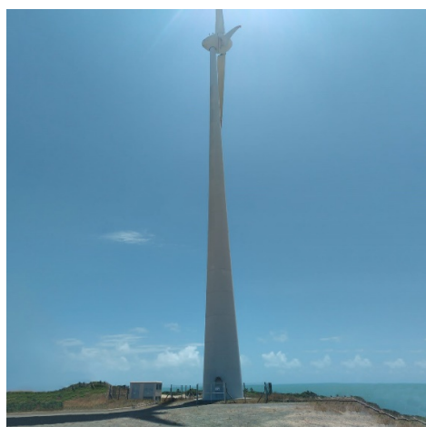
Figura 10 – Base de um dos aerogeradores do Parque eólico de Uberaba.
