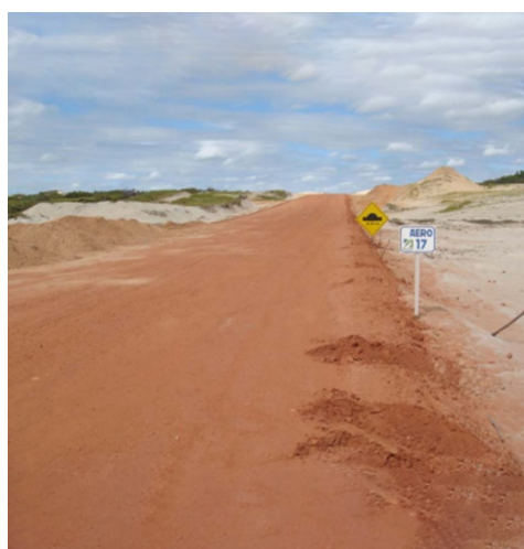
Figura 9 – Estrada interna do Parque Eólico de Parajuru já concluída.
