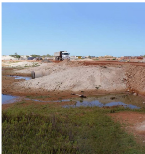
Figuras 7 e 8 – Construção de estrada sobre uma lagoa na UEE Parajuru.
