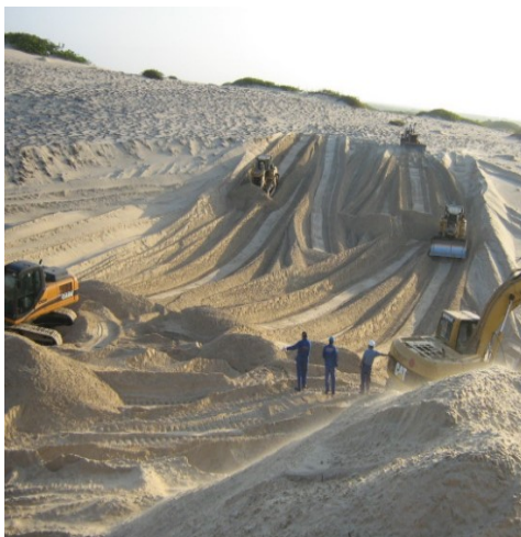
Figura 4 e 5 – Construção de estradas internas em dunas de areia da UEE do Rio Choro.
