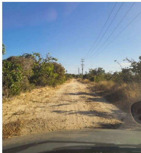
Figura 14 – Linha de transmissão da Eólica Beberibe (Sítio Novo).
