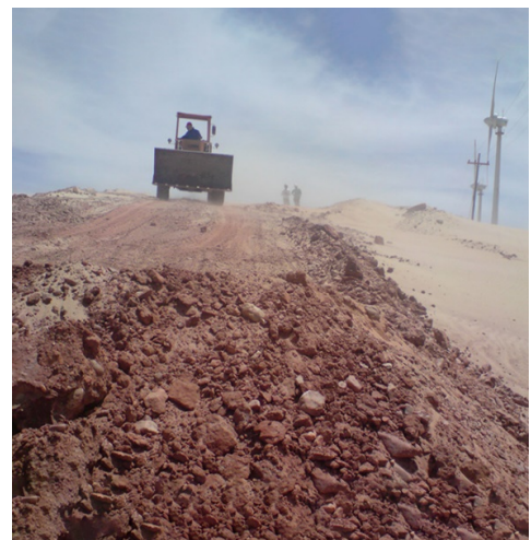
Figura 4 e 5 – Construção de estradas internas em dunas de areia da UEE do Rio Choro.
