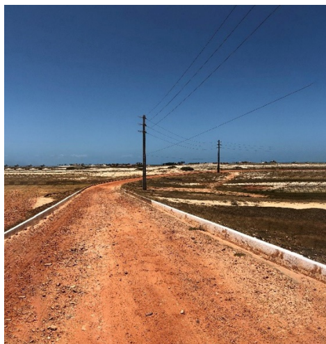
Figuras 6 – Estrada externa da UEE Foz do Rio Choró concluída.
