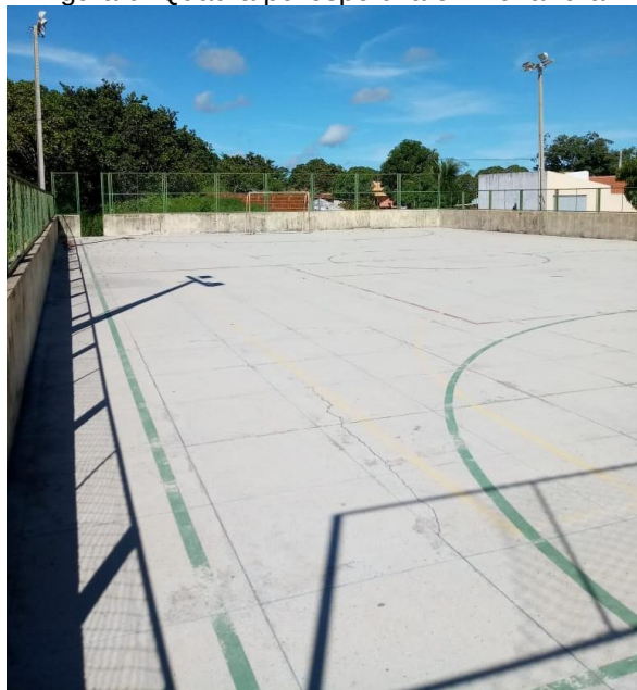
Figura 9: Quadra poliesportiva em zona rural.
