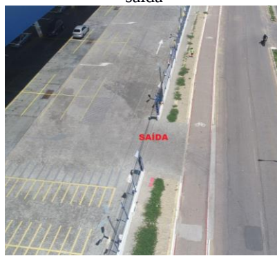
Figura 14 – Ausência de sinalização adequada na saída
