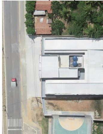
Figura 11 – Ausência de sinalização adequada em frente a uma escola
