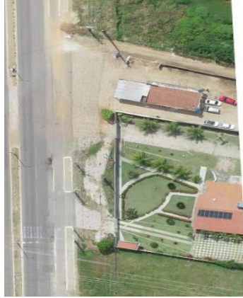
Figura 9 – Ausência de sinalização adequada
