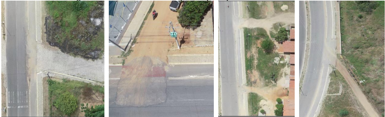
Figura 10 – Ausência de sinalização adequada para acesso de vias locais
