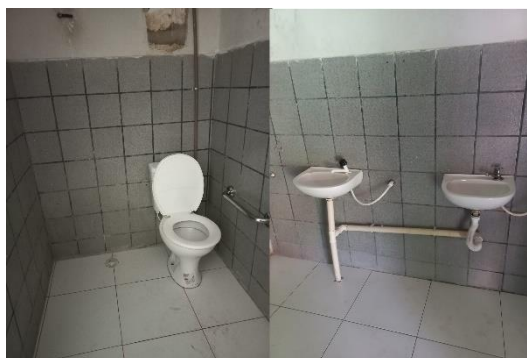
Figura 6 – Banheiro acessível da escola
