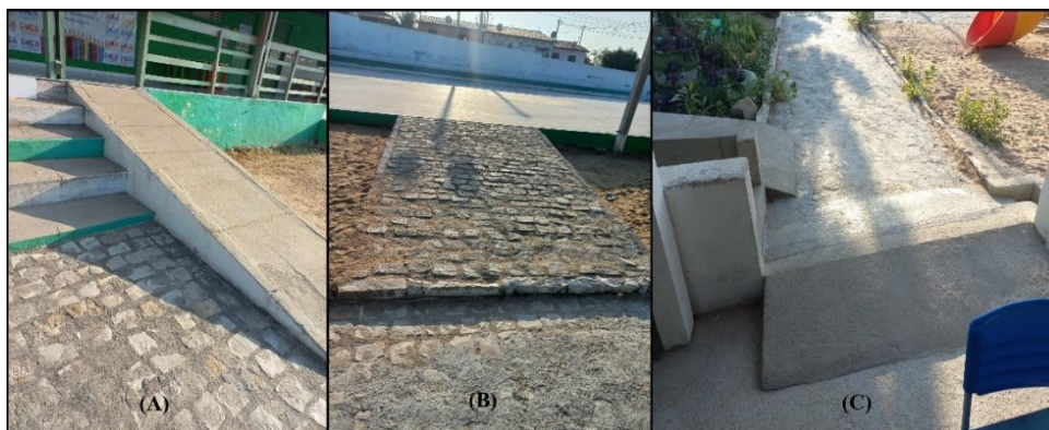
Figura 3 – Acesso interno na escola para diferentes espaços. (A) salas de aula; (B) quadra de esportes; (C) refeitório.
