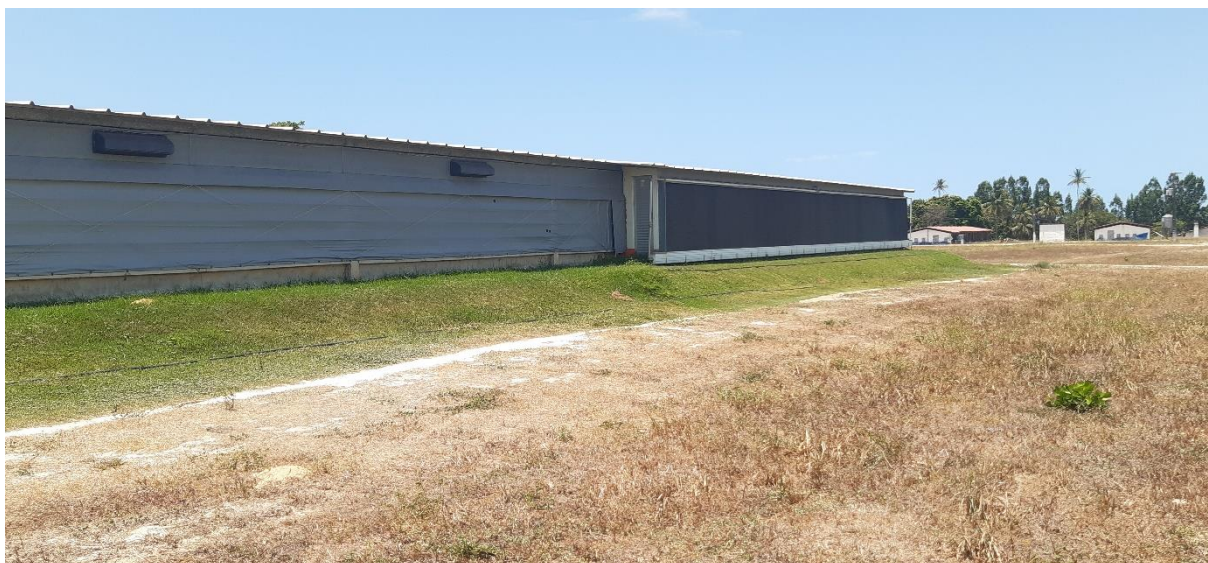
Figura 8. Galpão Dark House.
