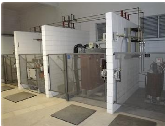
FIGURA 1. Subestação abrigada [4].
