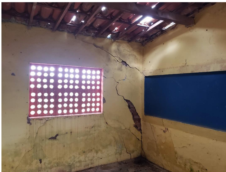
Figura 40 - Vista interna do grupo escolar.
