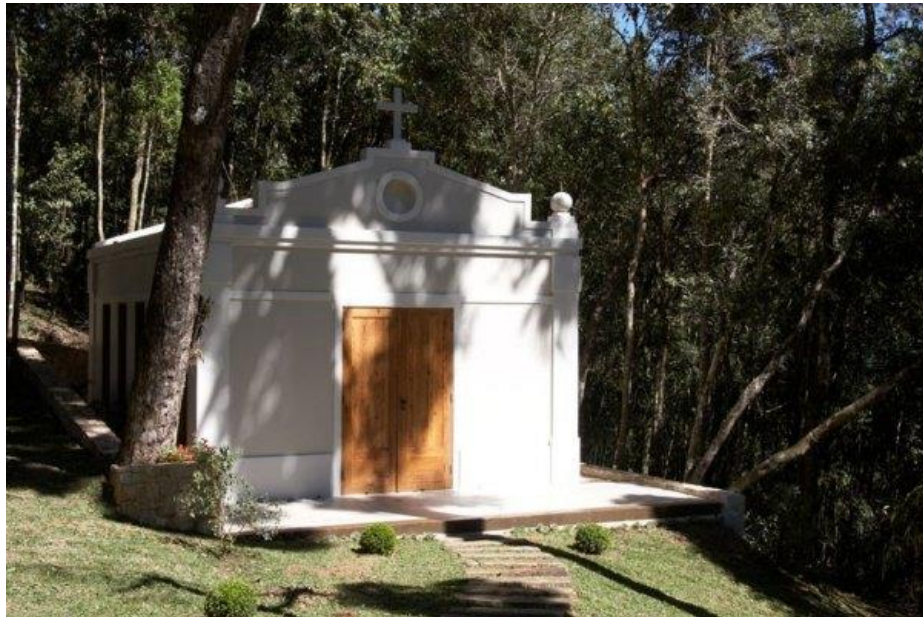
Figura 35 - Fachada da capela e seu entorno.
