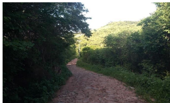
Figura 12 - Estrada do Sítio Guardado seção pavimentada de pedras
