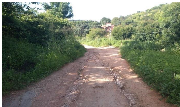
Figura 11 - Estrada do Sítio Guardado seção não pavimentada de pedras
