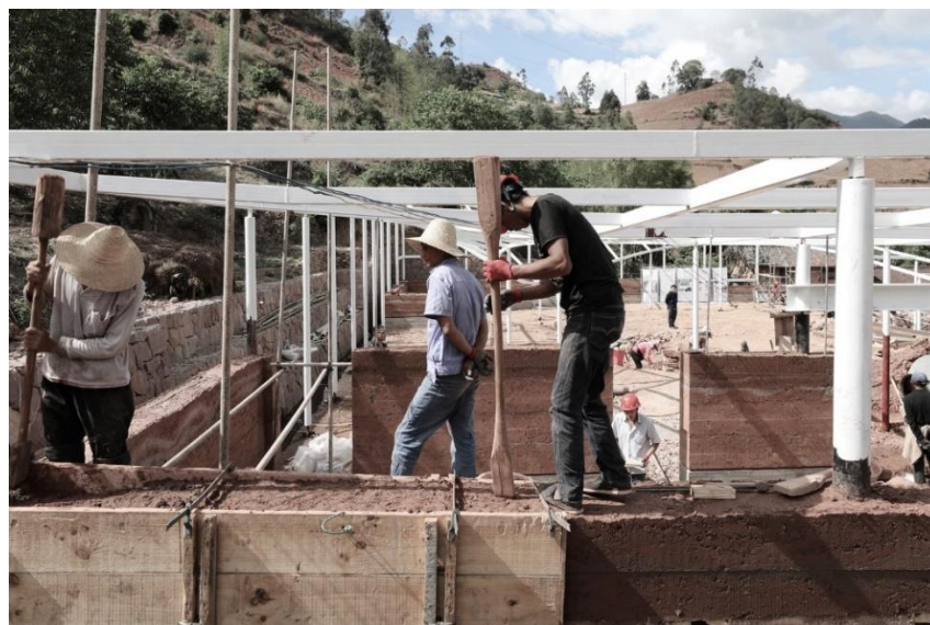
Figura 31 - Edificação em processo de construção, paredes de adobe.
